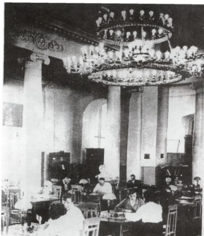
Читальный зал библиотеки ВГУ (бывшее здание Михайловского кадетского корпуса)
